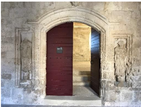
Statues à l'entrée du réfectoire © Centre des monuments nationaux
