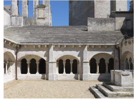
Cour intérieure du cloître avec arcatures et contreforts © Geoffroy Mathieu / Centre des monuments nationaux
